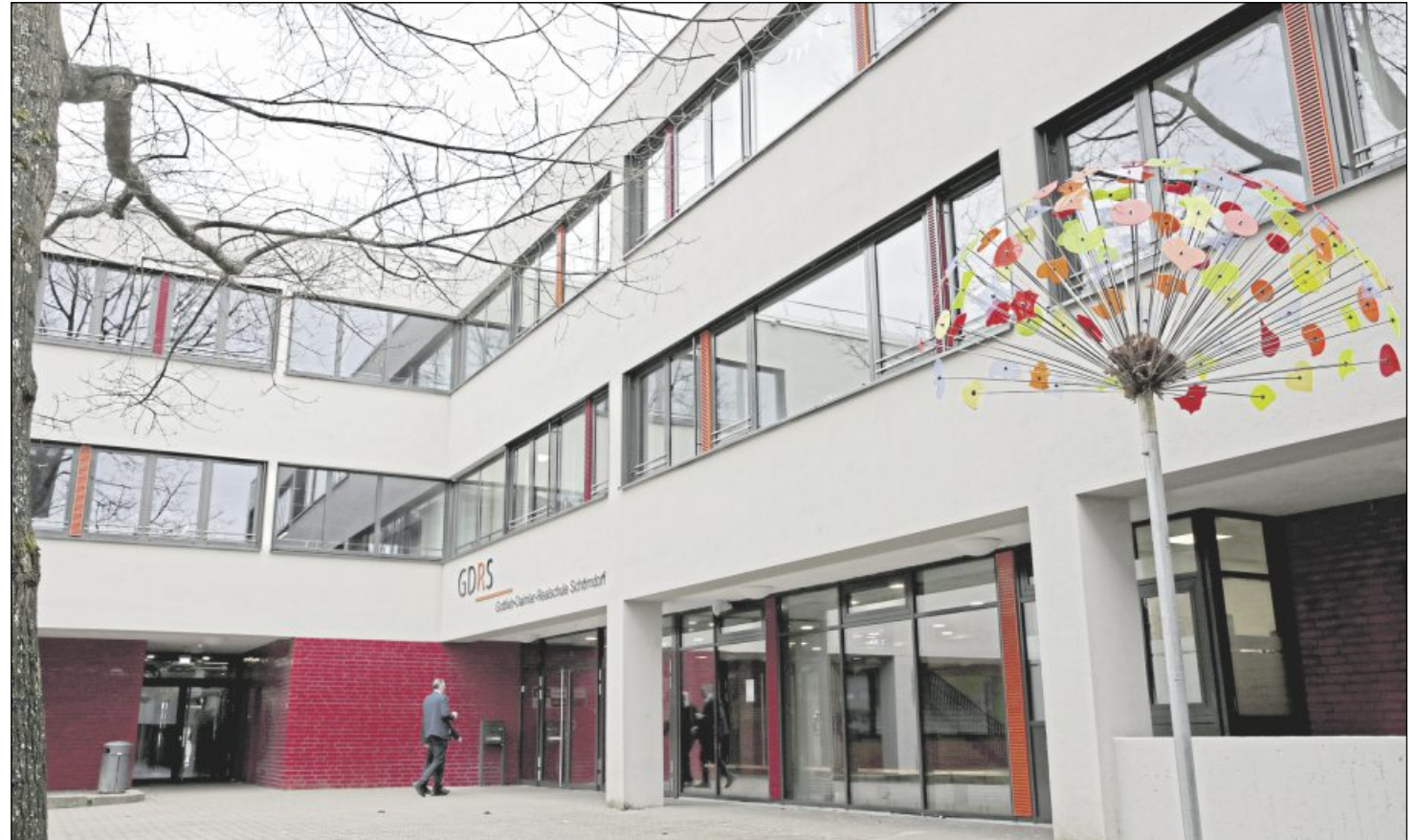
Die Sanierung der Gottlieb-Daimler-Realschule hat sich auf drei Bauabschnitte erstreckt – von 2018 bis 2022.
