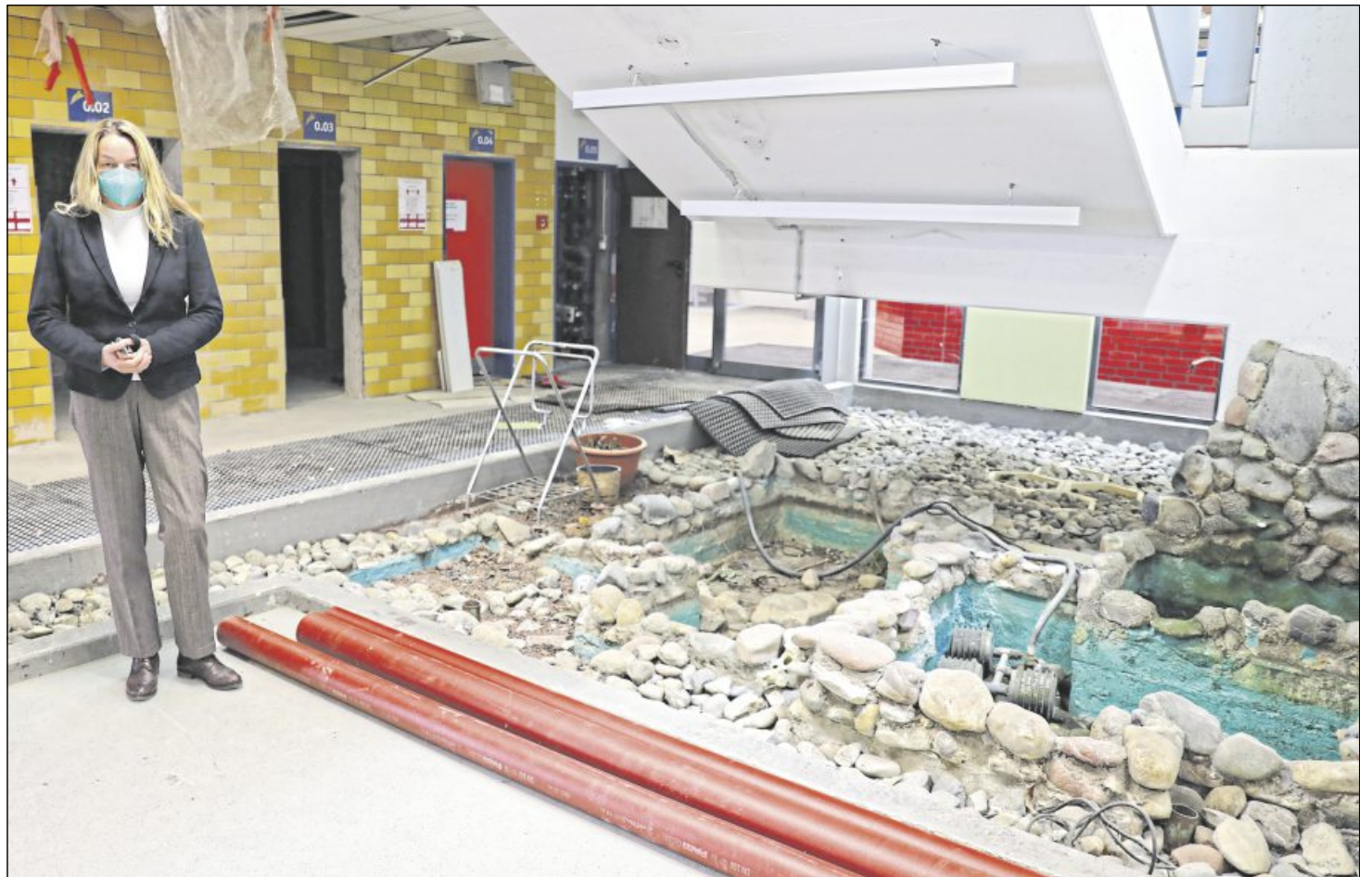
Schulleiterin Beate Flemming-Nikoloff vor dem Teich. Der ist derzeit eine Baustelle.
