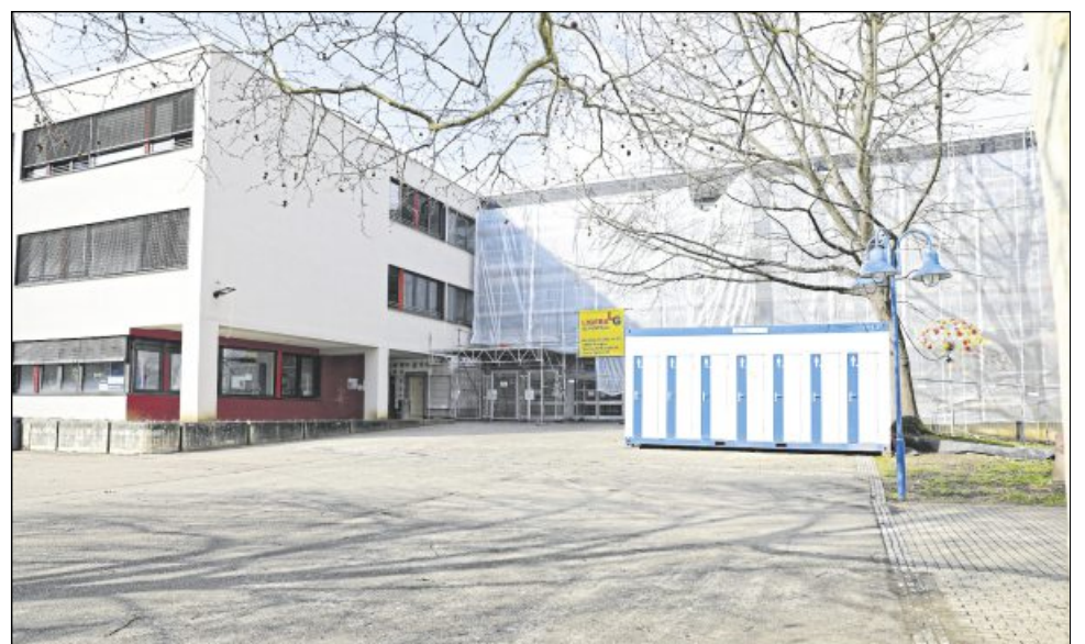
Die Gottlieb-Daimler-Realschule befindet sich mitten in den Sanierungsmaßnahmen.
