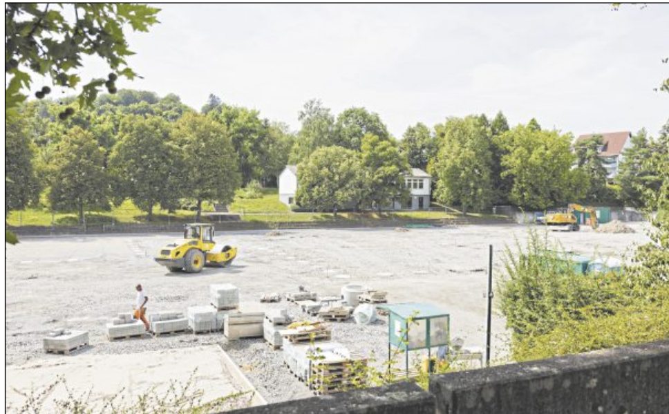
Der Bau des neuen Sportplatzes Grauhalde schreitet voran.
